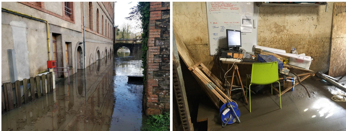
Parking de la filature le 3 janvier 2024 et état du bureau après la crue
